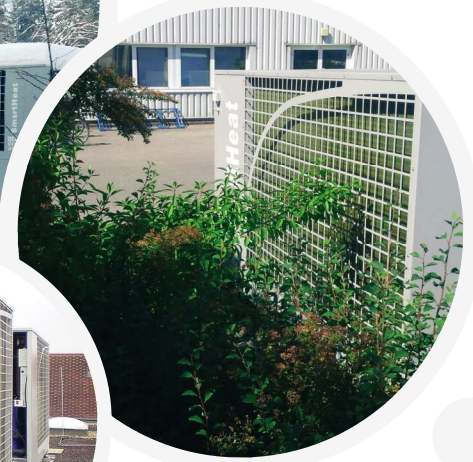
SmartHeat aero 088 多台机组串联使用 SmartHeat aero 088 units in cascade arrangement
